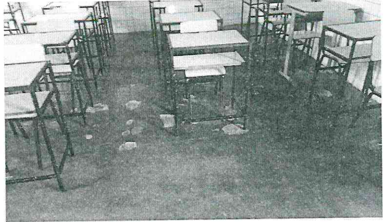
Piso de cimento queimando com ranhuras.
